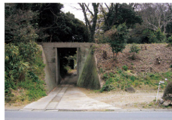
10 工事が途中でストップしたまぼろしの渥美線の痕跡(石神町)
