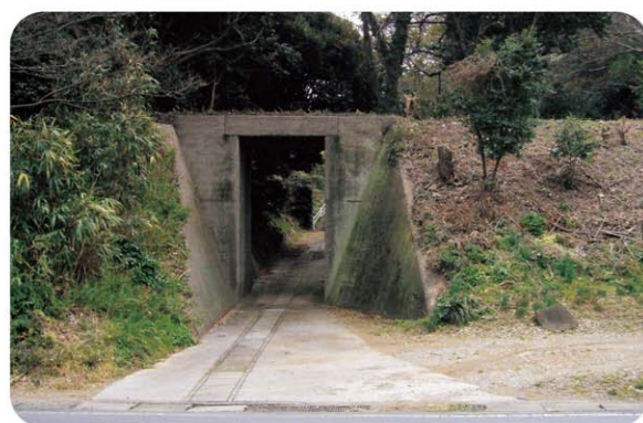
国道から見えるコンクリート橋(石神町)
