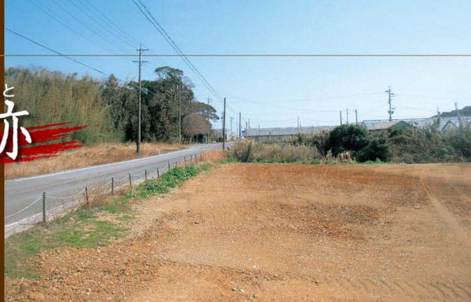
和地城周辺の現況(西より) 左の森は三島神社
